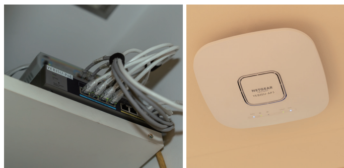
バックヤードに設置された MS108TUP と売り場の WAX625。 日常業務を前提に、安定した通信環境を構成している。
